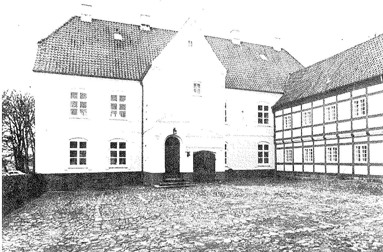
Haraldskær set fra gårdsiden. Det store firkantede trappetårn med de uens døre er et konservativt træk. Sidefløjen i bindingsværk ser meget gammel ud, men den er opført så sent som i 1917 af fabrikant C. M. Hess.
